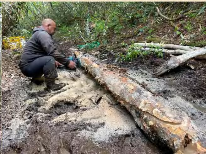
引きずり出した倒木を半割にして木道に施工する。
