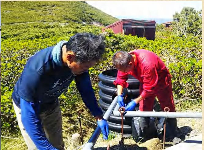
固液分離ろ過装置組み立て
